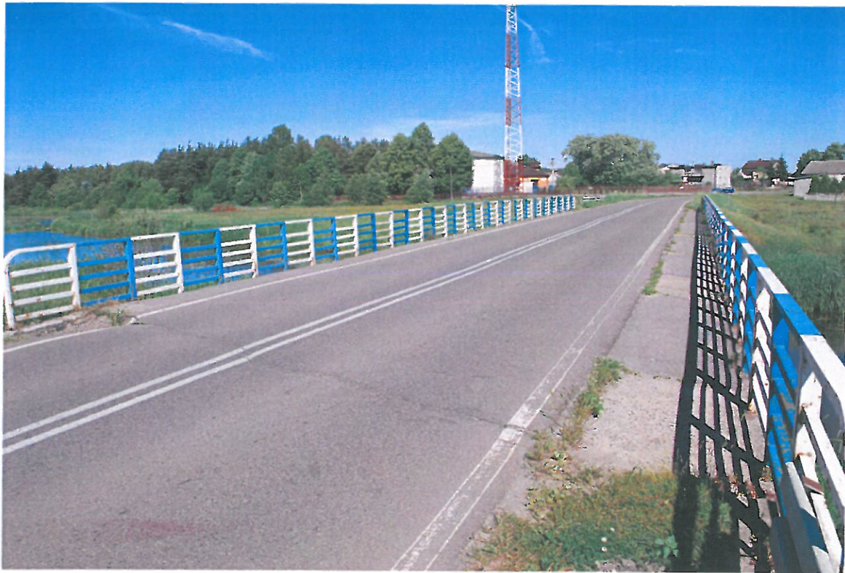
Fot. 1. Widok od strony południowej
