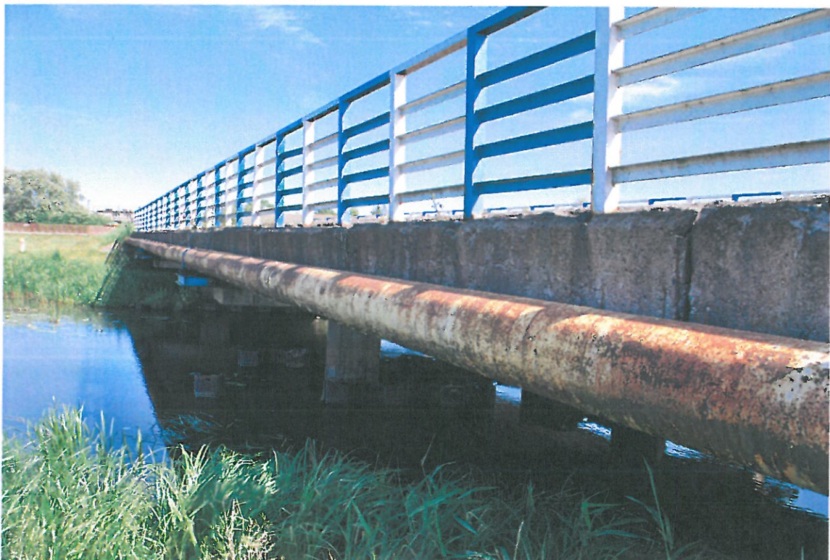
Fot. 2. Widok wzdłuż mostu od strony dolnej wody
