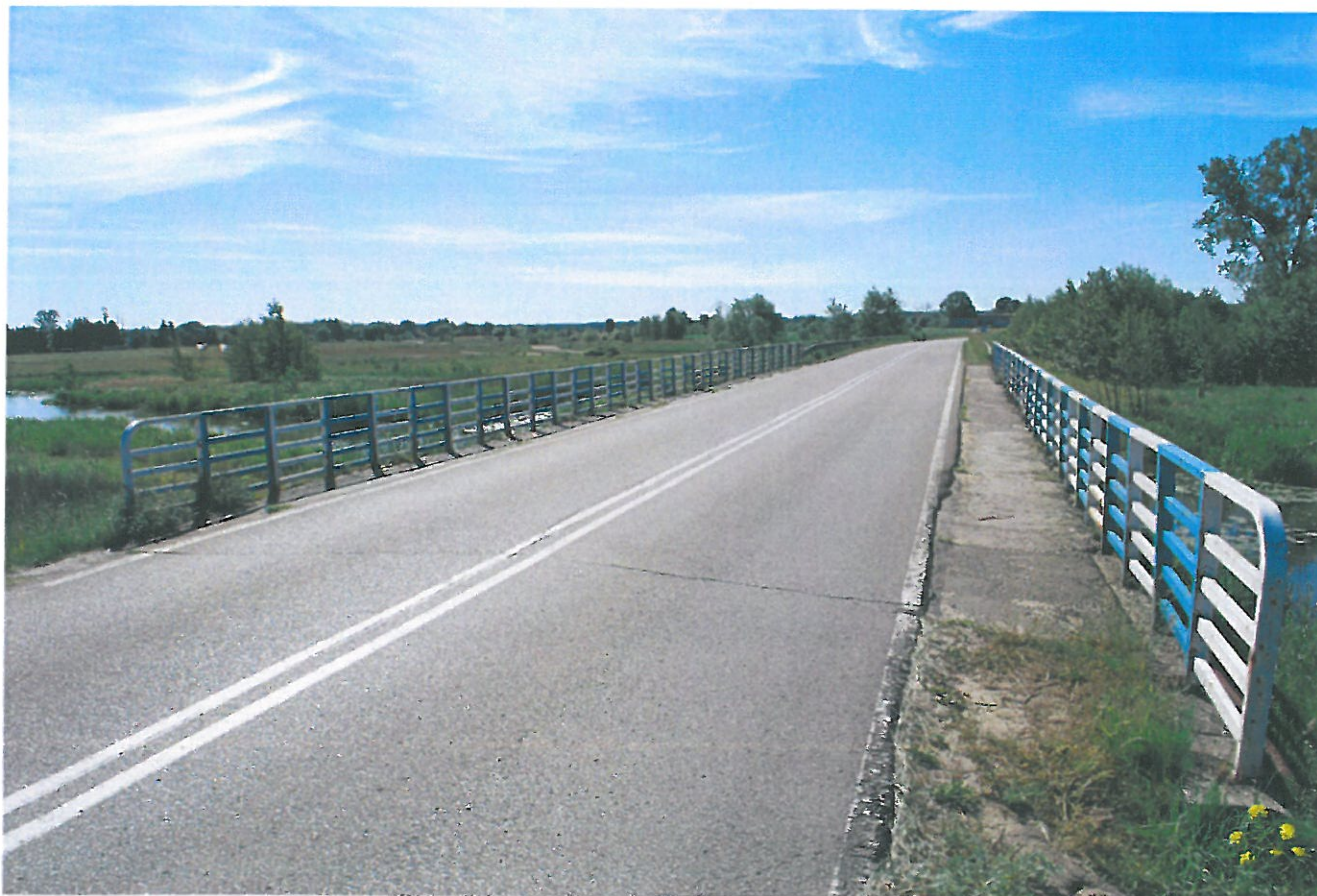
Widok ogólny mostu
