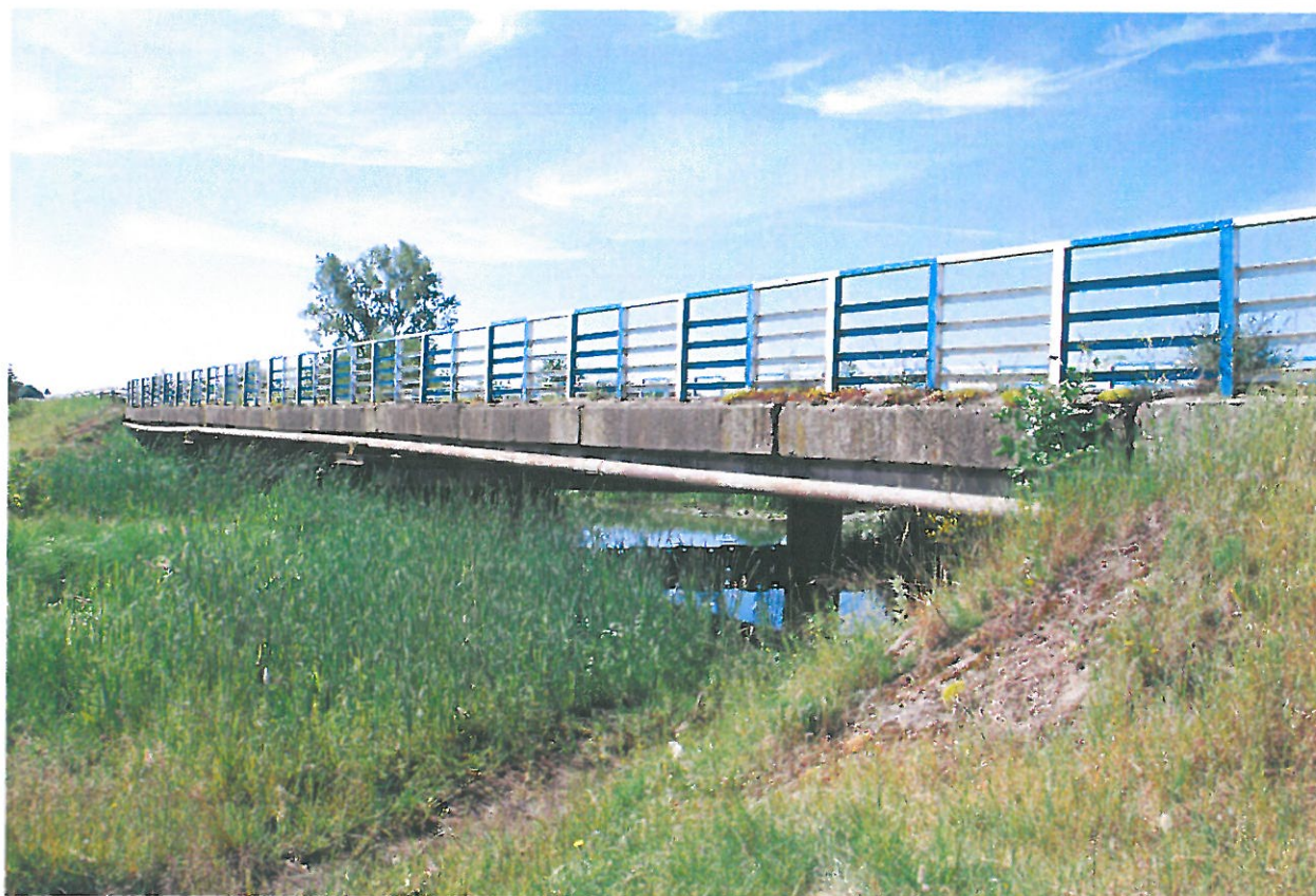
Fot. 3. Widok wzdłuż mostu od strony górnej wody
